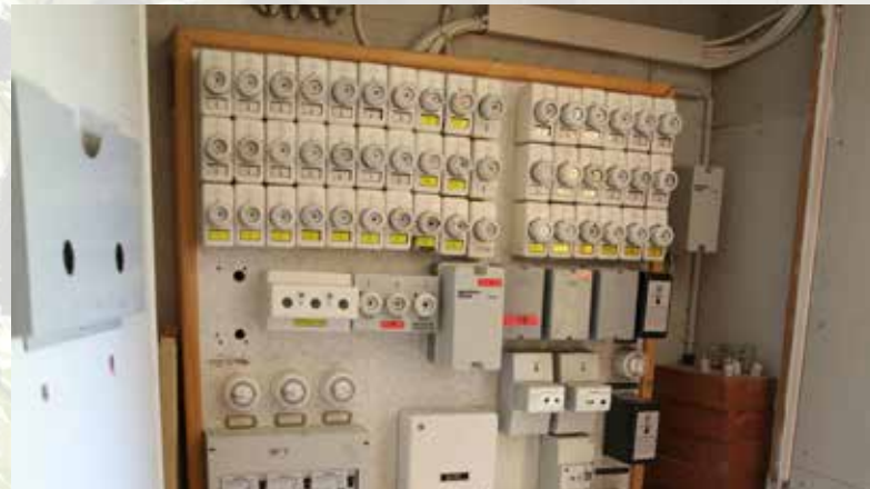
Sanierungsbedürftige Elektroinstallation
