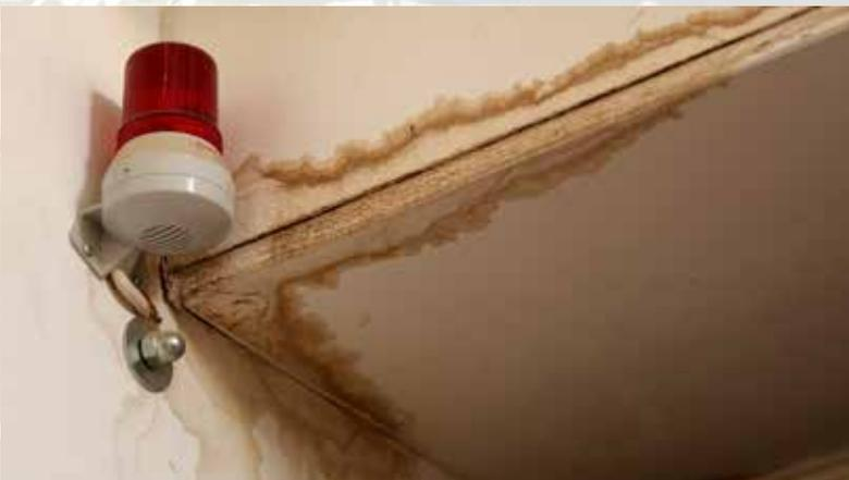
Undichtes Dach (Totalsanierung nötig)
