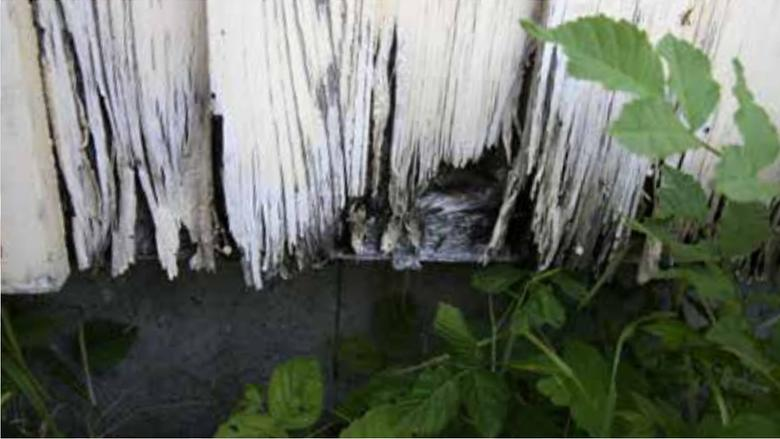
Defekte Fassade mit nicht zeitgemässer Wäremedämmung
