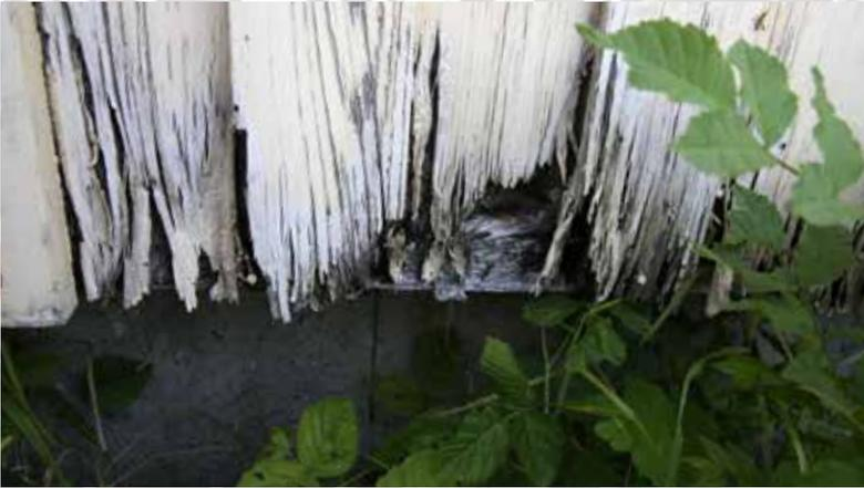
Defekte Fassade mit nicht zeitgemässer Wäremedämmung
